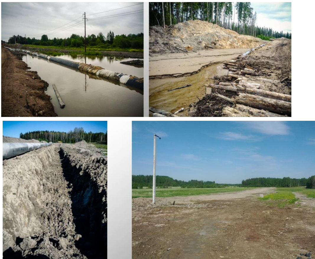
Рисунок 8. Фотографии площадки и траншеи под укладку газопровода «Северный поток» на участке ОАО «Ленгазспецстрой» с текучими глинами (глубина – до 10 м): вверху – до стабилизации; снизу – после применения глубинной стабилизации грунта
