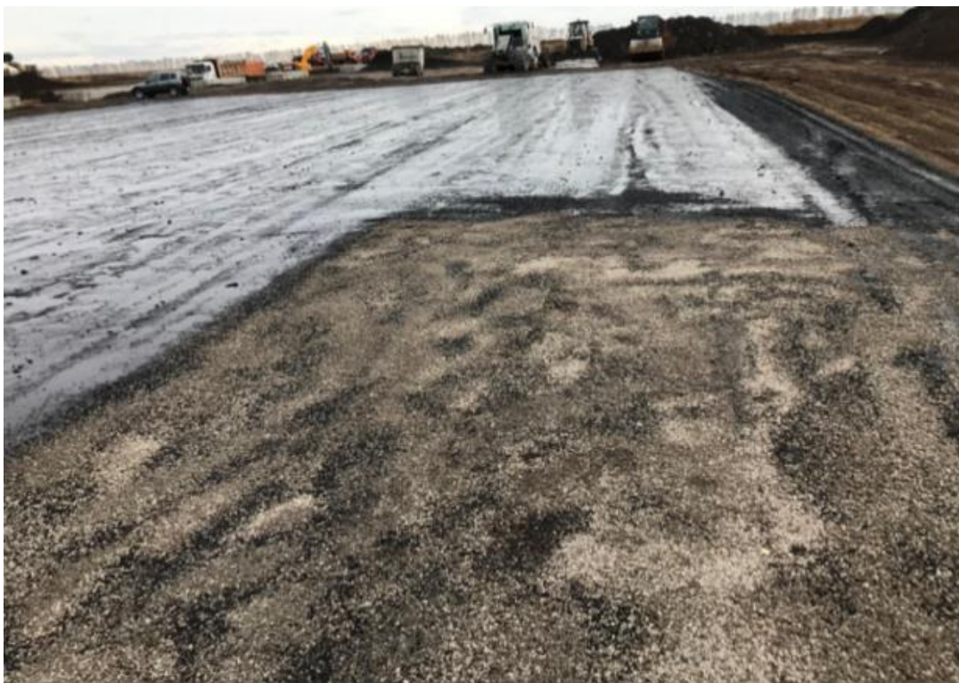
Рисунок 13. Устройство защитного слоя покрытия по методу «двойной чип-сил» с нанесением битумной эмульсии и щебня непосредственно на укрепленный грунтовый слой
