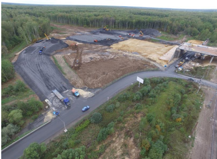
Рисунок 11. Фото объекта строительства компании «Стройтрансгаз» «Автомобильная развязка на пересечении с железной дорогой вблизи деревни Жилево, Московская область» в котором были использованы стабилизированные золошлаковые материалы Каширской ГРЭС
